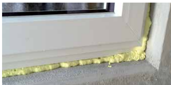
Abb. 04: Der ausgehärtete DuPont™ Insta Stik™ Flex+ kann nun besäumt werden
