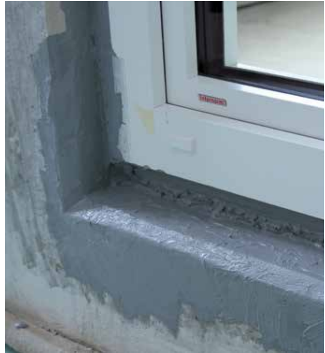
Abb. 05: Auftrag von DuPont™ LiquidArmor™ CM im Bereich des Fensterbankanschlusses
