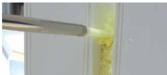
Abb. 03: Ausfüllen der Fuge mit DuPont™ Insta Stik™ Flex+
