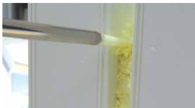
Abb. 03: Ausfüllen der Fuge mit DuPont™ Insta Stik™ Flex+
