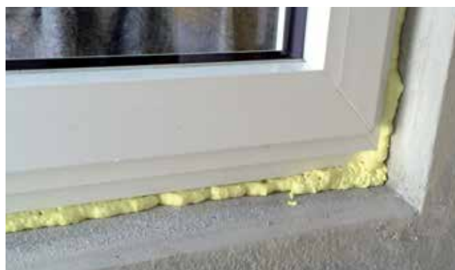
Abb. 04: Der ausgehärtete DuPont™ Insta Stik™ Flex+ kann nun besäumt werden
