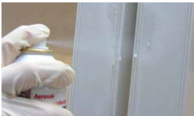
Abb. 02: Die erforderliche Vorbereitung der Oberflächen mittels Grundierung
