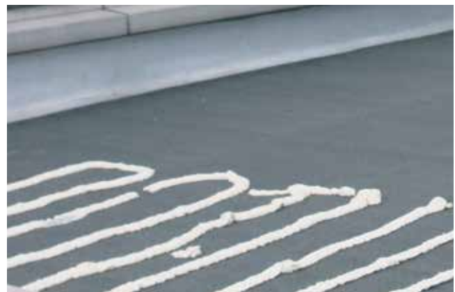
Abb. 06: Auftrag von DuPont™ Insta Stik™ D
