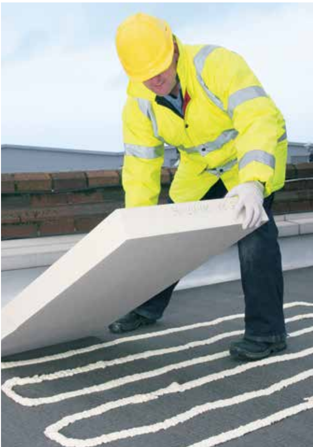
Abb. 04: Auftrag von DuPont™ Insta Stik™ D
