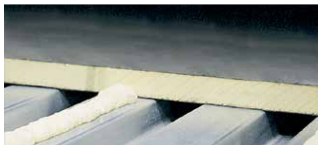
Abb. 02: Verklebung einer kaschierten PU-Dämmplatte auf ein Stahlprofil
