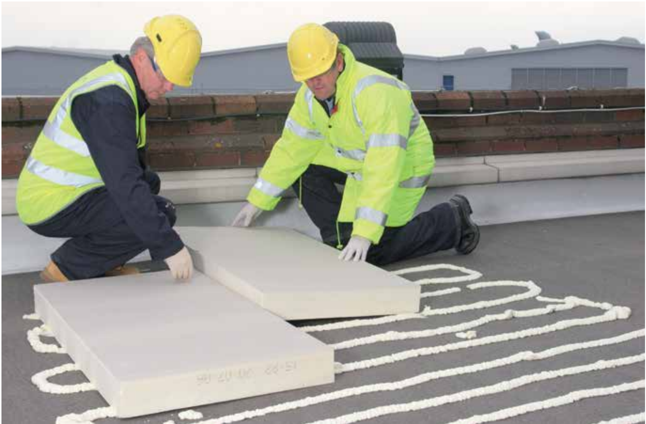
Abb. 05: Auftrag von DuPont™ Insta Stik™ D
