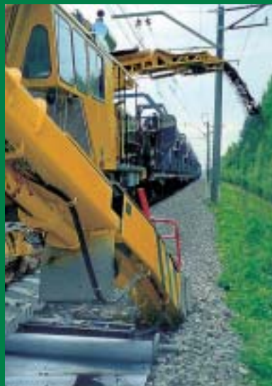
Oprava železniční tratě Moskva–Petrohrad (Rusko)
