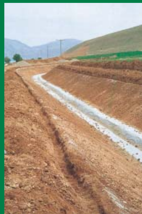
Odvodňovací příkop (Německo)
