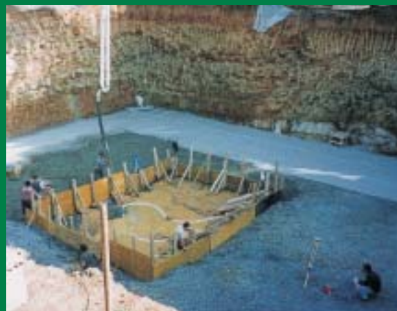
Výstavba budovy (Turecko)
