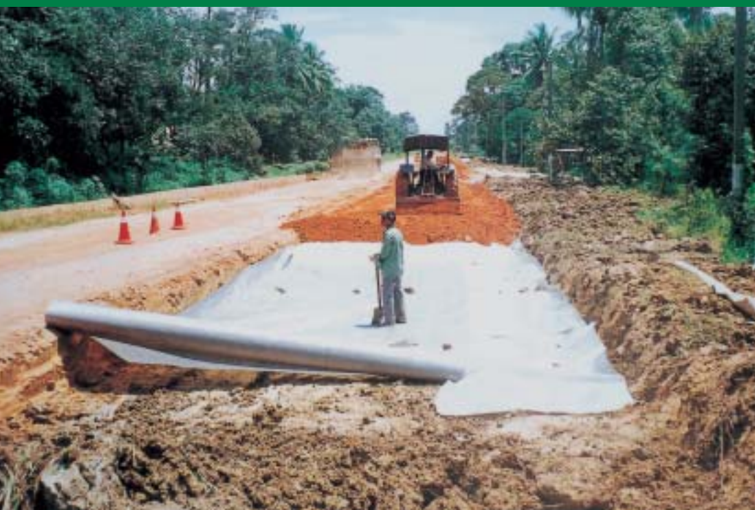
Výstavba komunikace (Malajsie)
